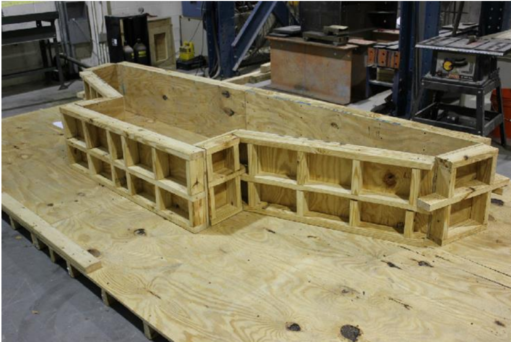
Figure D1. Formwork
