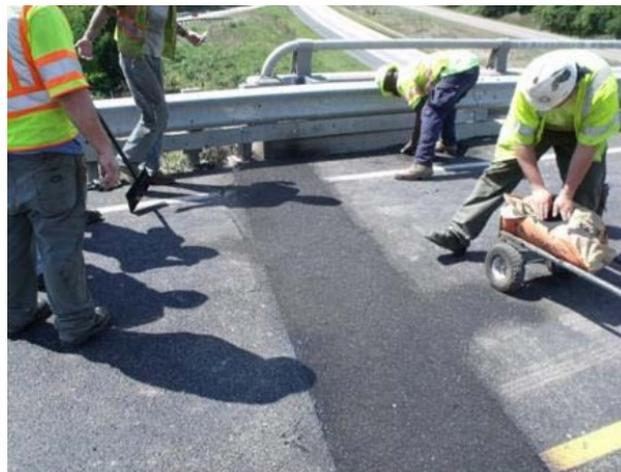
**Fig. 10: Asphalt Plug Joints**
