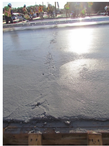
Figure 195: Block-out after pour
