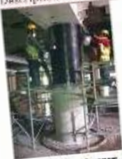
Figure 2 : Photo du renforcement
