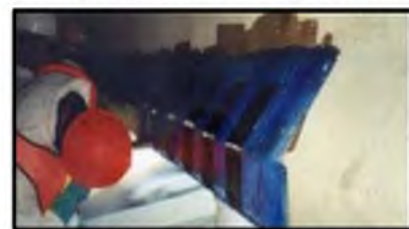
f) Strip Manual Lay-Up CFRP Sheet
