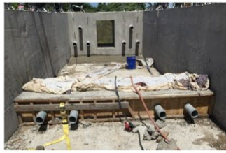
(d) Casting of the deviator
