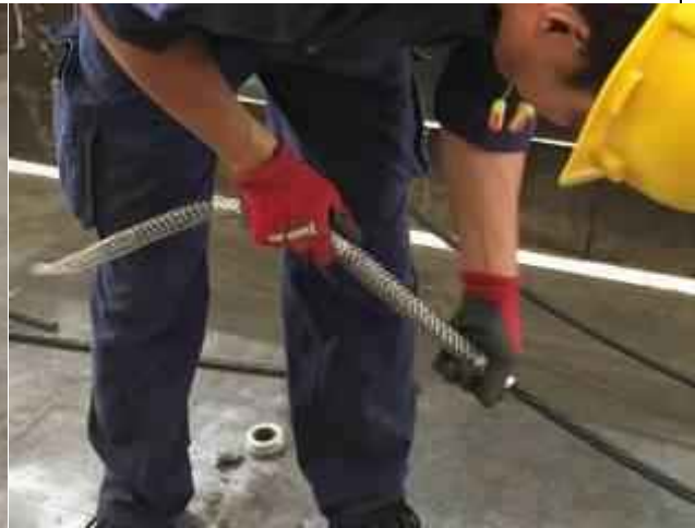
(d) Placing braid grip over buffer material
