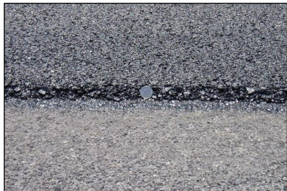
(d) Fracture-tolerant interlayer system
