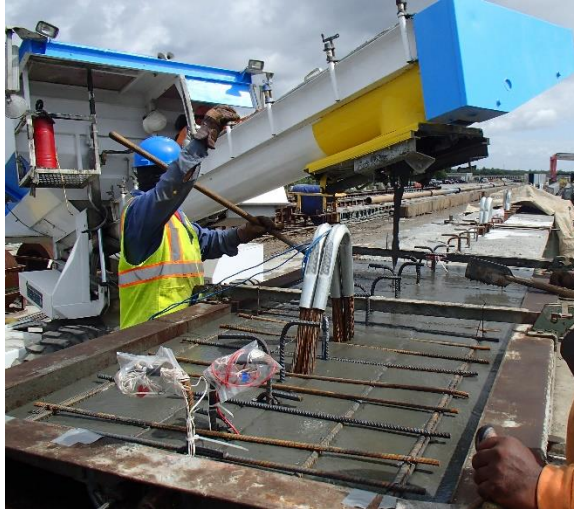
Figure 3-15 UHPC pour using Tuckerbilt buggy
