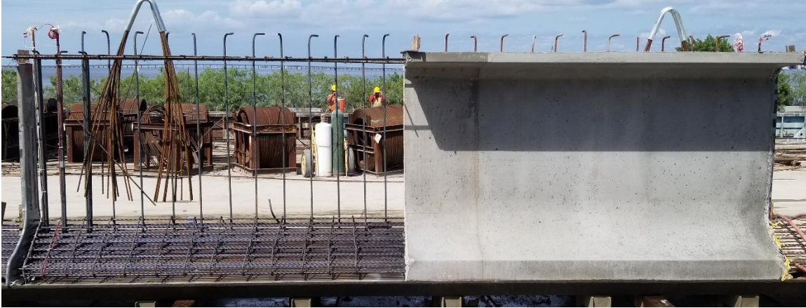
Figure 3-12 G2 before UHPC pour
