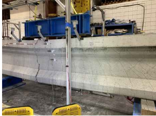
(b) Girder E2
