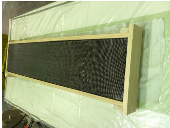
(d) Laying carbon fiber sheets
