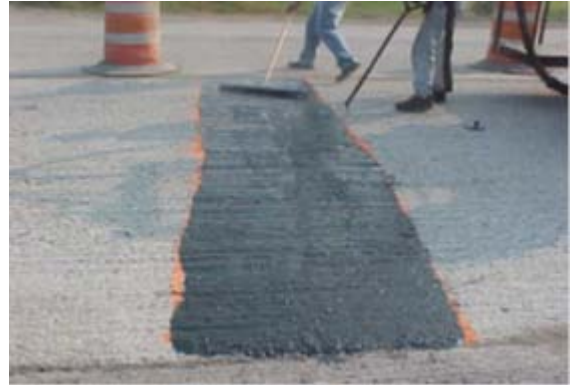
(d) Spreading the AC cement
