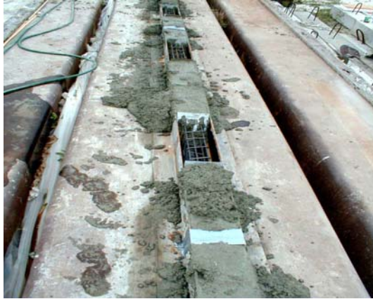
Regular Concrete Pour
