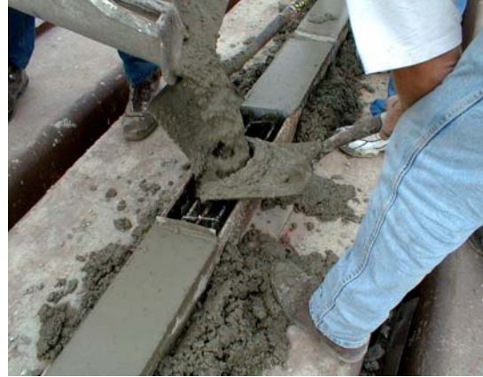
Daracel Added Concrete Pour
