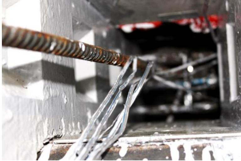
Figure 64–Epoxy in closure pour
